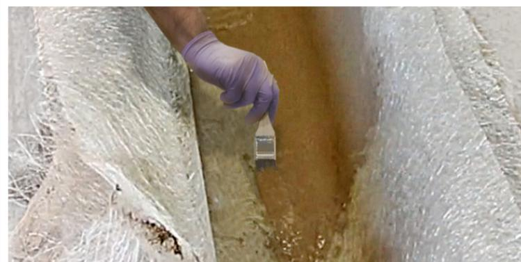
**3** Se aplican capas alternantes de Forton® MG y vidrio tipo 'E' hasta llegar a la anchura deseada, típicamente 10mm (3/8").
