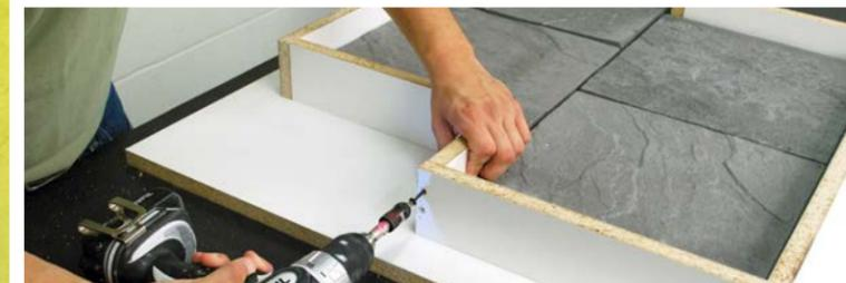
**1** Se construye una caja con el contorno de los adoquines.
