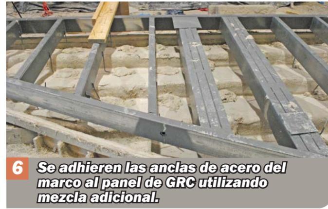
**6** Se adhieren las anclas de acero del marco al panel de GRC utilizando mezcla adicional.
