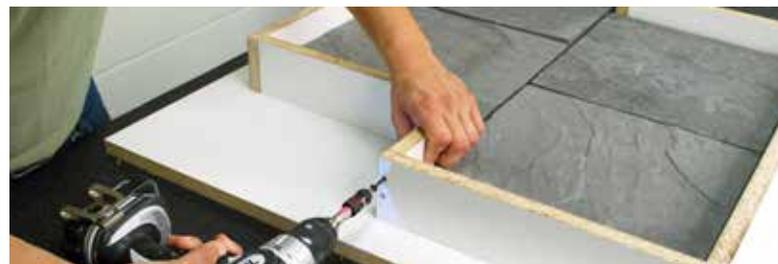
**1** Se construye una caja con la forma de los adoquines.
