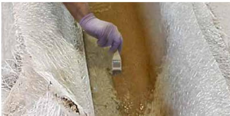
**3** Se aplican capas alternando Forton® MG y fibra de vidrio tipo 'E' hasta llegar a la anchura deseada típicamente 10mm (3/8").
