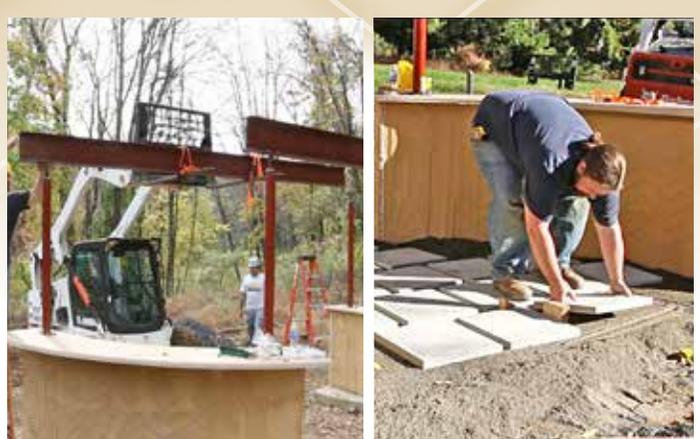
**10** Se añaden una pérgola de acero y adoquines para completar el espacio.
